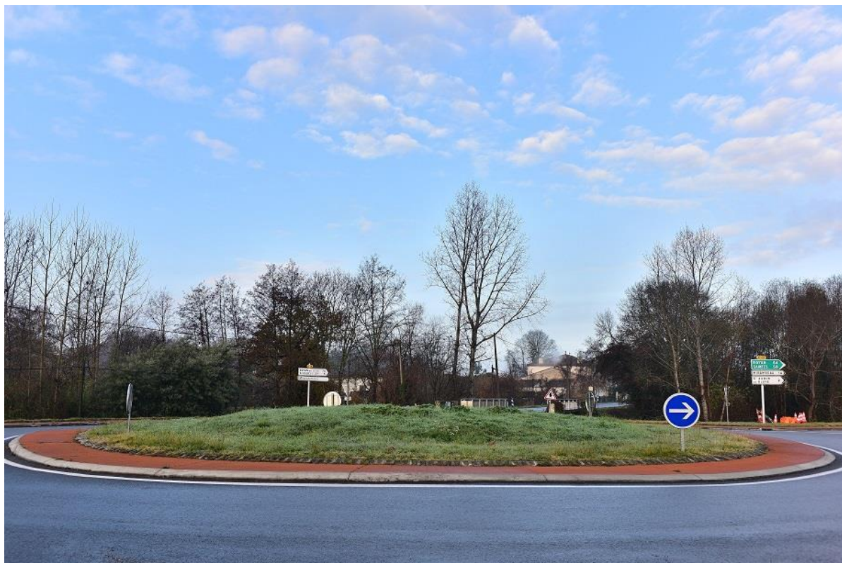
Photo du rond-point avant les travaux (Photo François MAURISSE)
